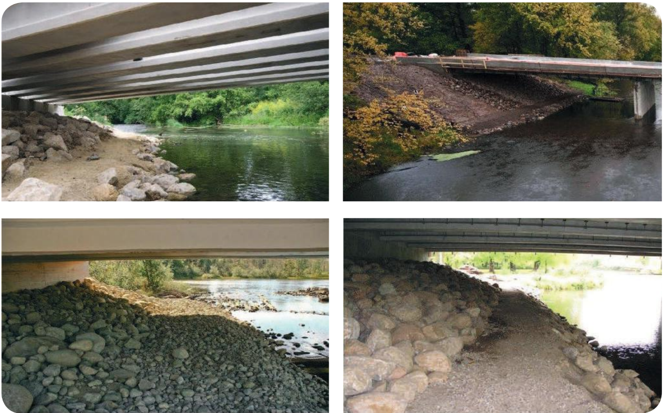
Figura 5. Ejemplos de estructuras viales de cruces con cuerpos de agua con adecuaciones que permiten el paso de la fauna silvestre
