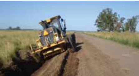
Imagen Nº 1 - Reconstrucción con extracción lateral
