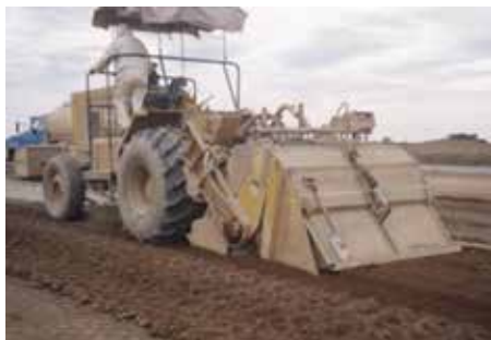
Imagen N° 27 –Mezclado in situ
