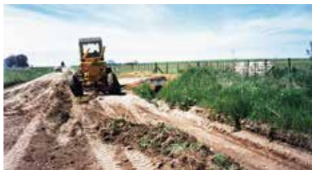
Imagen N° 7 - Conformación de perfil adecuado
