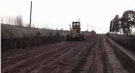
Imagen Nº 2 - Perfilado con extracción lateral
