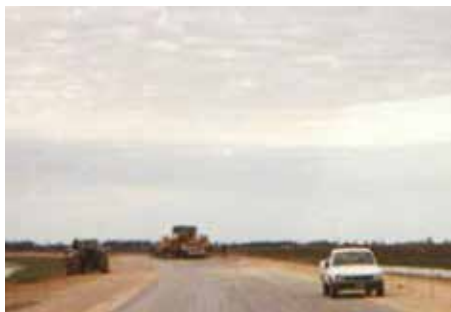
Imagen N° 31 – Superficie terminada cubierta con riego asfáltico
