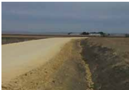
Imagen N° 14 - Cuenta de desagüe longitudinal
