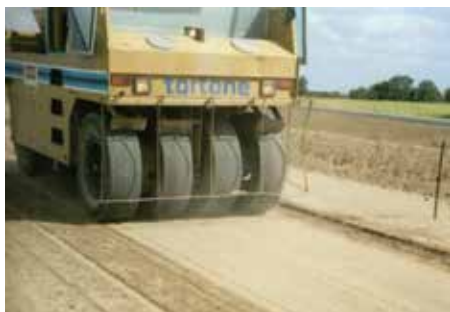
Imagen N° 30 –Compactación con rodillo neumático
