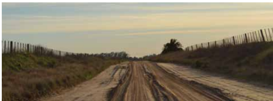
Imagen N° 6 - Perfil de camino en desmonte
