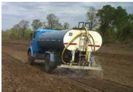
Imagen N° 25 –Regado del suelo con camión cisterna
