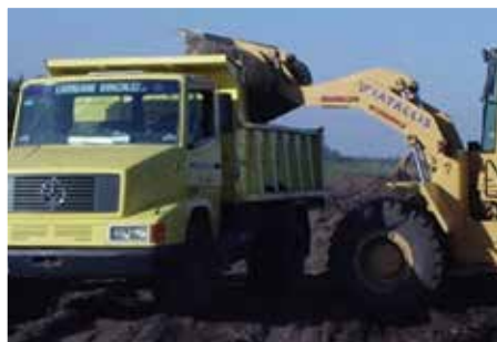
Imagen N° 5 - Alteo con transporte de suelo
