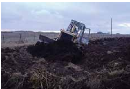
Imagen N° 4 - Alteo con extracción lateral
