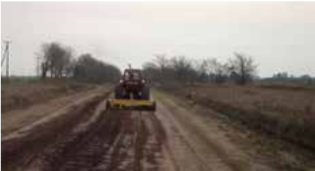
Imagen Nº 3 - Perfilado sin extracción lateral
