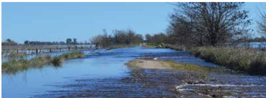
Imagen N° 2 - Debido a la falta de un perfil adecuado se deposita el agua en la calzada
