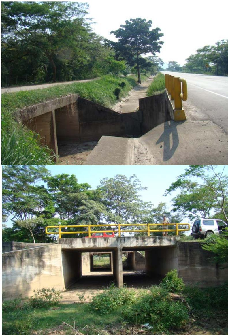
Figura 7. Estructura para paso de ganado debajo de la carretera al sur de Curumaní, Cesar.. Este cruce es muy útil para fauna. Se debe adaptar el substrato por tierra o arena y promover el crecimiento de arbustos dentro del túnel. Ya que la entrada de luz lo permite. Foto: Panthera.
