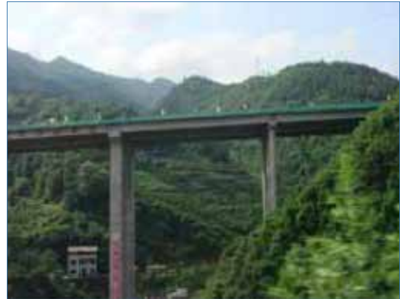
Viaductos en áreas sensibles en la autopista Yiba, China
