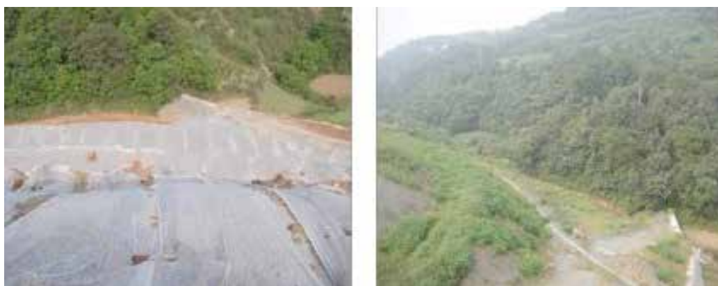
Figura 15. Restauración de las áreas de préstamo
