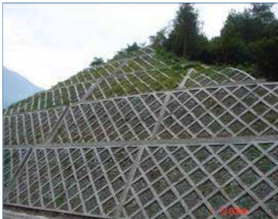
Figura 8. Estabilización de taludes y métodos para el control de la erosión
