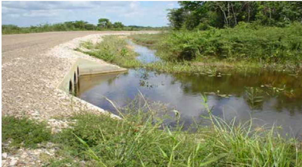
Figura 21. Mantenimiento del flujo del agua
