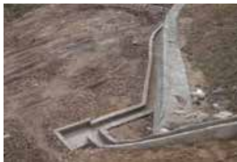
Canaleta para el efluente del agua residual tratada
