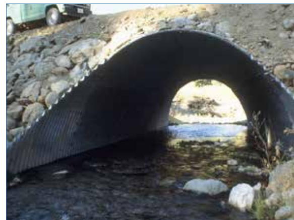
Instalación apropiada de un culvert
