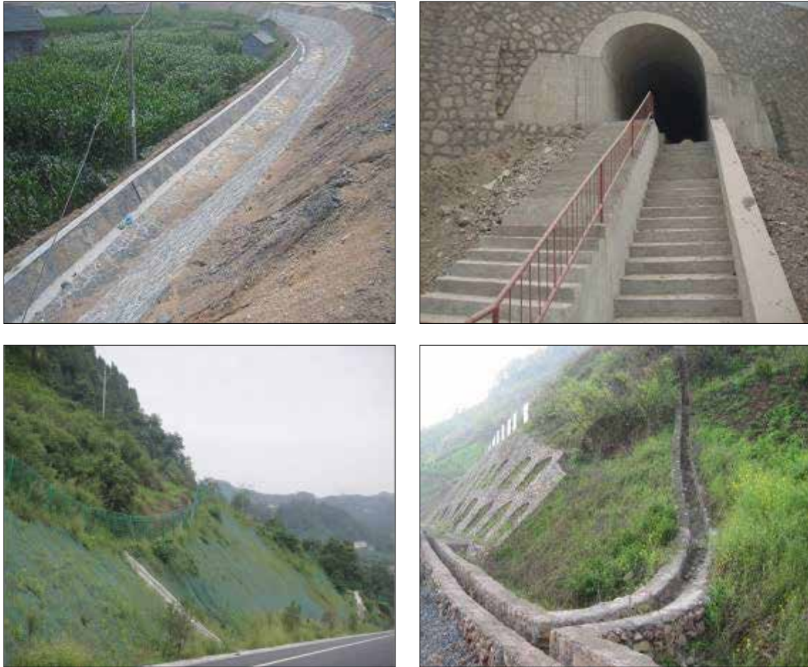
Figura 11. Estructuras de drenaje
