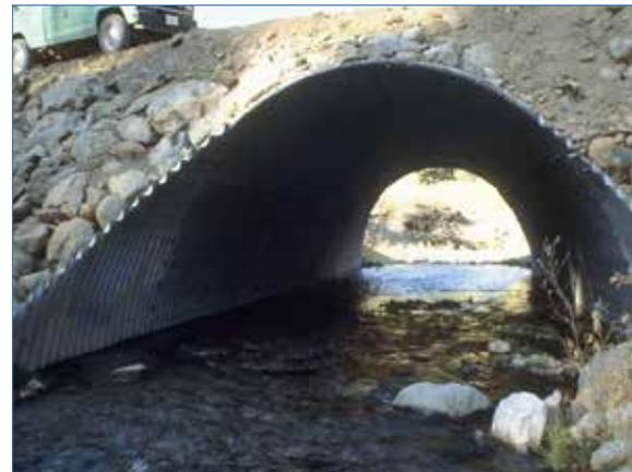
Instalación apropiada de un culvert
