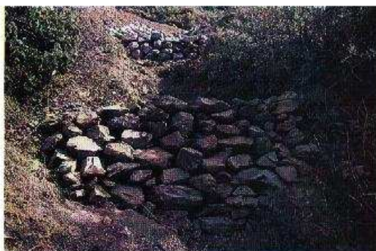
Foto 12-7. Un dique de contención de piedra recién construido en una cárcava formado por la escorrentía de un camino. Nótese la ausencia de vegetación en la cárcava. Huchuetenango, Guatemala. (Foto G. Bauer)
