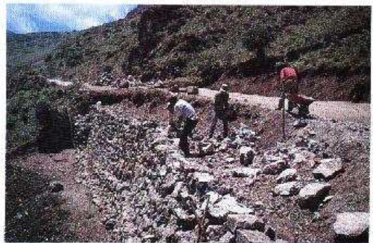
Foto 10-10. La construcción de un muro de contención de piedra típica hecha con labor manual. Baja Verapaz, Guatemala. (Foto G. Bauer)
