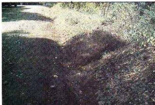
Foto 9-5. Un canal de desviación para desaguar la cuneta. Esta estructura sería más efectiva con un camellón en la cabeza para dirigir el agua hacia afuera. Bosque Nacional Plumas, California, EE.UU. (Foto G. Keller)
