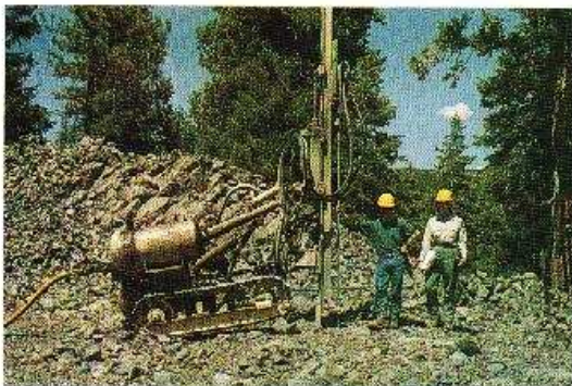
Foto 13-11. Un ejemplo de maquinaria liviana utilizada para perforar roca sólida. Bosque Nacional Plumas, California, EE.UU. (Foto G. Keller)
