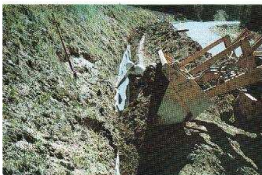
Foto 9-17. La instalación de un subdrenaje (subdrén) geocompuesto para desaguar el corte de talud. Bosque Nacional Sierra, California, EE.UU. (Foto G. Keller)
