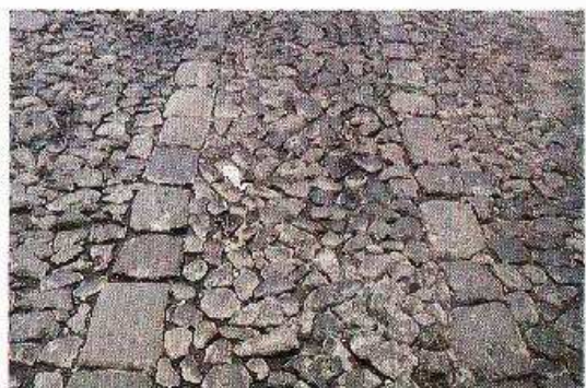
Foto 13-6. Una vista de cerca de un proyecto de empedrado recién terminado. Esta superficie durará muchos años si se mantiene bien. Guatemala, Guatemala. (Foto G. Keller)
