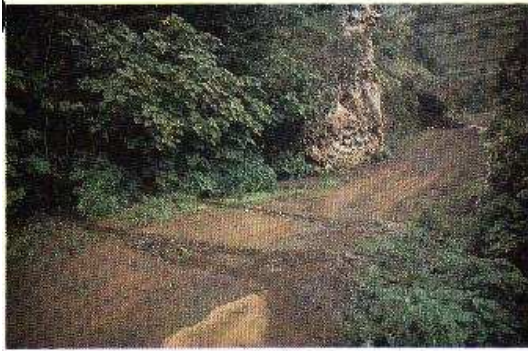
Foto 7-1. Un badén sin mejoras que atraviesa un camino de material nativo. La erosión causará la falla de la superficie y/o deslizamientos. Huchuetenango, Guatemala. (Foto G. Bauer)
