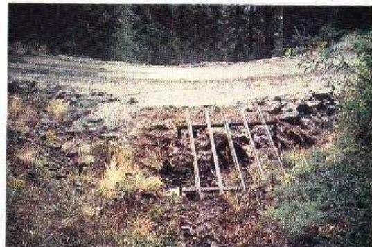
Foto 9-12. Una percha de desechos en la entrada de una alcantarilla para prevenir que se obstruya. Bosque Nacional Plumas, California, EE.UU. (Foto G. Keller)
