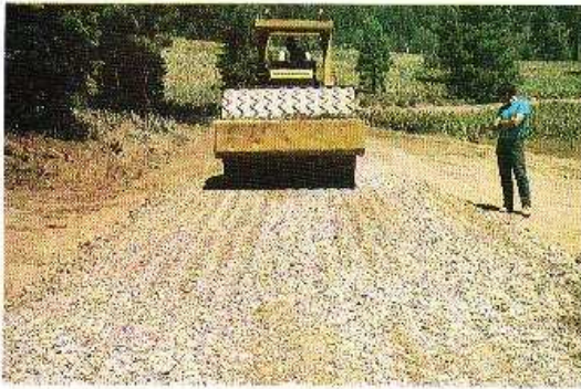
Foto 13-7. El uso de maquinaria de compactación aumenta la resistencia de materiales provenientes de bancos de préstamo. Bosque Nacional Plumas, California, EE.UU. (Foto G. Keller)
