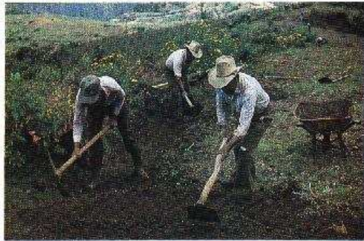
Foto 3-4. El uso intensivo de mano de obra es un método no costoso para construir y mantener caminos rurales. Huchuetenango, Guatemala. (Foto G. Keller)
