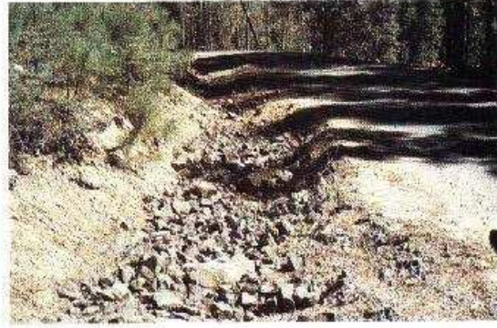
Foto 9-2. Un ejemplo de una cuneta revestida que protege el camino de las fuerzas erosivas. Bosque Nacional Plumas, California, EE.UU. (Foto G. Keller)
