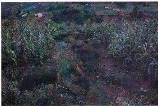
Foto 12-3. El inicio de erosión en cárcava en una parcela causado por agua desaguando de un camino. Huehuetenango, Guatemala. (Foto G. Keller)
