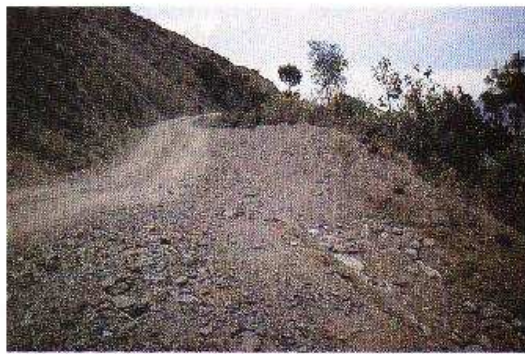
Foto 9-16. Un ejemplo de un drenaje revestido (a la derecha) que sale de un badén. Huehuetenango, Guatemala. (Foto G. Bauer)
