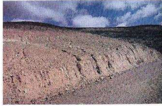
Foto 11-2. Erosión laminar y en canales en una ladera natural y un corte de talud sin protección. Se puede corregir esta situación con técnicas vegetativas, sembrando gramíneas y arbusto. Cochabamba, Bolivia (Foto GB)
