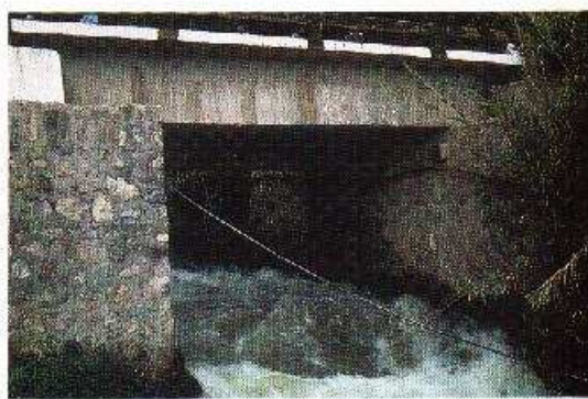
Foto 6-6. Un puente de concreto con cimientos asentados en el lecho rocoso. En este caso la socavación y el mantenimiento es mínimo. Huchuetenango, Guatemala. (Foto G. Keller)
