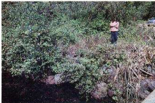
Foto 11-9. Ejemplo de la técnica de siembra de vegetación entre piedras para proteger la orilla de un riachuelo y un camino. En este caso sembraron sauce entre el zampeado. Bosque Nacional Plumas, Calif. EE.UU. (Foto G. Keller)
