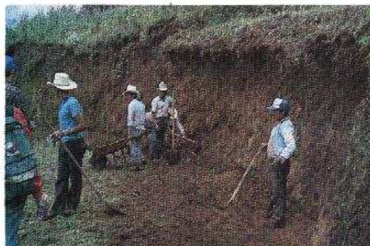
Foto 10-5. Una cuadrilla de trabajadores manuales limpiando las cunetas y los cortes de talud. El exceso de mantenimiento puede causar erosión, porque la vegetación sirve para frenar la corriente. Huehuetenango, Guate.
