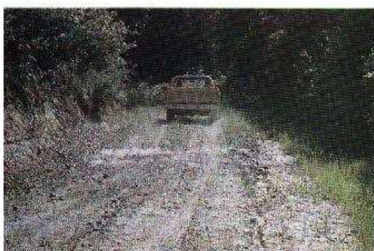
Foto 9-15. Los badenes sin alcantarilla para desaguar caminos son económicos y fáciles de construir con mano de obra. Bosque Nacional Plumas, California, EE.UU. (Foto G. Keller)
