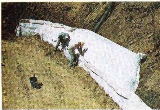
Foto 5-5. Un ejemplo de geotextil utilizado en un subdren geocomposito para drenar el corte de un camino. Bosque Nacional Plumas, California, EE.UU. (Foto G. Keller)
