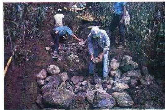
Foto 12-4. El inicio de la construcción de un dique de contención de piedra y bambú para controlar la erosión. Huehuetenango, Guatemala. (Foto G. Bauer)
