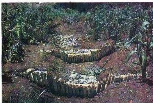
Foto 12-5. Un dique de contención terminado. Nótese como el dique está anclado en el suelo y los elementos amarrados un a otro. Estacas vivas de sauce han sido sembradas también. Huehuetenango, Guatemala. (GK)
