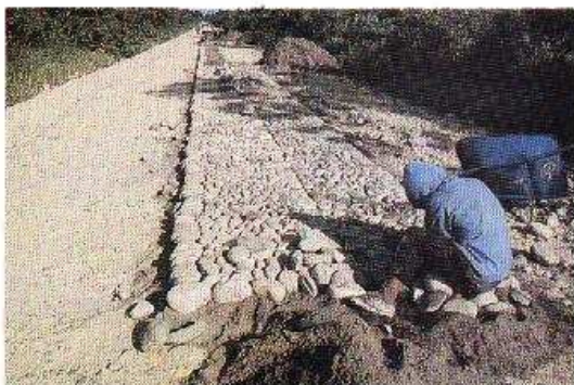
Foto 13-5. Un camino rural empedrado. Este método utiliza mano de obra intensiva y es muy resistente a la erosión y la formación de rodadura. Su costo de mantenimiento es relativamente bajo. Chapare, Bolivia.
