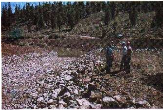
Foto 5-3. Se puede utilizar el zampeado para brindar protección a largo plazo a los canales de riachuelos. Bosque Nacional Plumas, California, EE.UU. (Foto G. Keller)
