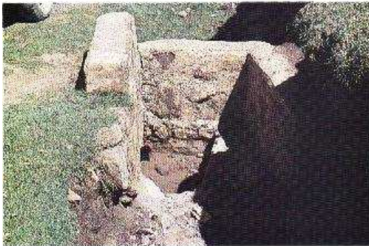
Foto 9-3. Una estructura de boca de caída típica para controlar la pendiente de la cuneta. Huehuetenango, Guatemala. (Foto G. Keller)
