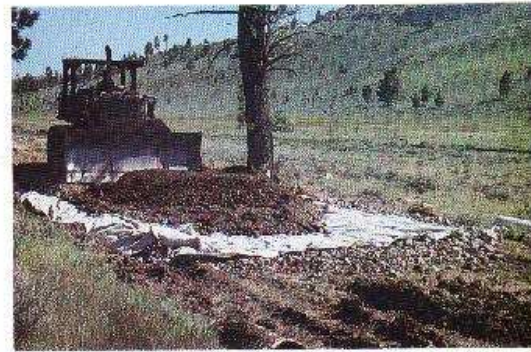
Foto 5-4. Se utiliza el geotextil para separar y reforzar el subrasante. Bosque Nacional Plumas, California, EE.UU. (Foto G. Keller)
