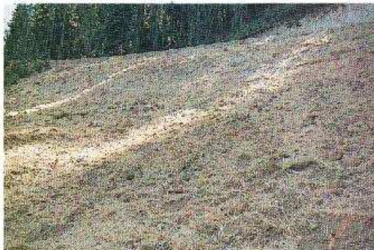
Foto 11-5. El uso de cubiertas retenedoras de humedad de paja y la siembra de otras plantas protegen los taludes, absorbiendo el impacto de la lluvia y disminuyendo la velocidad de la escorrentía. Bosque Nacional Plumas.
