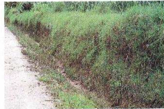
Foto 9-6. Una práctica de protección vegetativa. La siembra de los taludes con gramíneas brinda estabilidad al suelo a largo plazo, reduce al mínimo el costo de mantenimiento y previene la erosión. Quiché, Guate.
