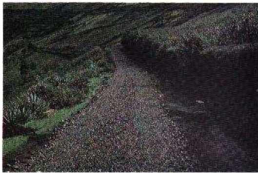
Foto 13-3. Un ejemplo de un camino rural de bajas normas con la plataforma estabilizada con canto rodado. Huehuetenango, Guatemala. (Foto G. Keller)
