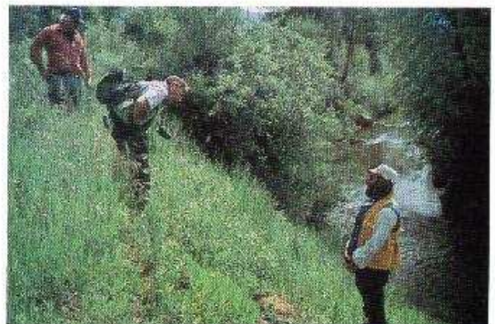
Foto 10-12. Un ejemplo de la técnica revegetativa de la aplicación de capas de ramas en un corte de talud. Bosque Nacional Plumas, California, EE.UU. (Foto G. Keller)
