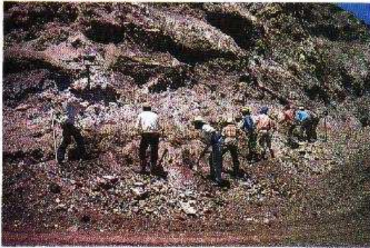
Foto 13-9. Un ejemplo del uso de mano de obra intensiva para excavar un banco de préstamo. Huehuetenango, Guatemala. (Foto G. Bauer)
