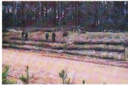
Foto 11-13. Un ejemplo de la técnica revegetativa de la aplicación de capas de ramas en un corte de talud. Georgia, EE.UU. (Foto de R.B. Sotir & Associates)
