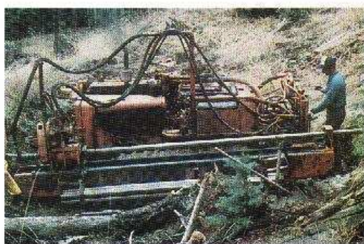
Foto 9-18. La instalación un drenaje horizontal para desaguar y estabilizar el talud. Bosque Nacional Plumas, California, EE.UU. (Foto G. Keller)
