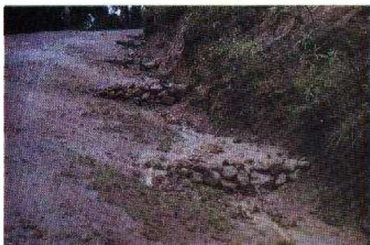
Foto 9-13. Un dique de piedras colocado dentro de una cuneta para disminuir la velocidad del agua y contrarrestar la erosión. Totonicapán, Guatemala. (Foto G. Keller)
