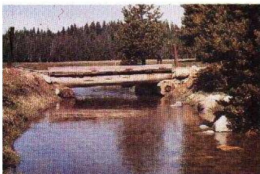
Foto 6-1 Un puente de tramo corto de trozos de madera bien construido. Bosque Nacional Plumas, California, E.U.U. (Foto G. Keller)
