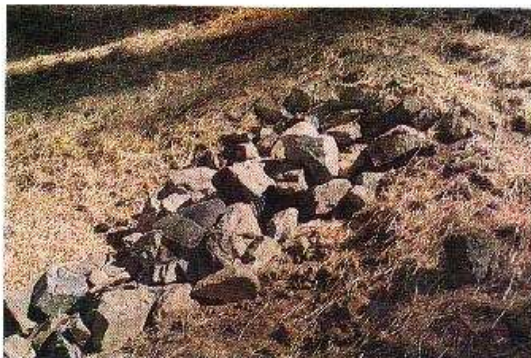
Foto 9-11. La salida de una alcantarilla protegida con zampeado. El área adyacente está sembrada con gramíneas y tiene una cubierta de humedad para protegerla mientras germinan las semillas. Bosque Nacional Plumas, Calif.
