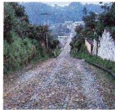
Foto 13-4. Un ejemplo de un camino muy transitado con la plataforma adoquinada. Totonicapán, Guatemala. (Foto G. Bauer)
