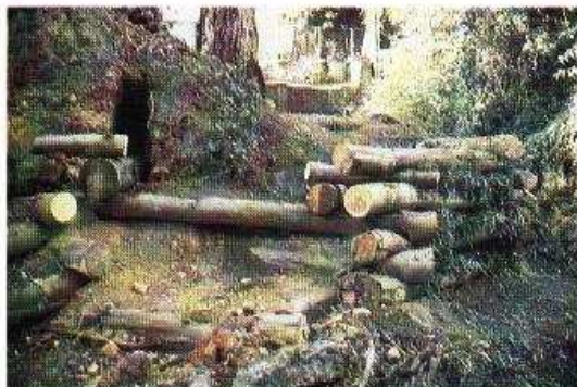
Foto 11-17. La construcción de un muro cribado vivo para estabilizar una área sujeta a la erosión. Oakland hills, California, EE.UU. (Foto A. Leiser)
