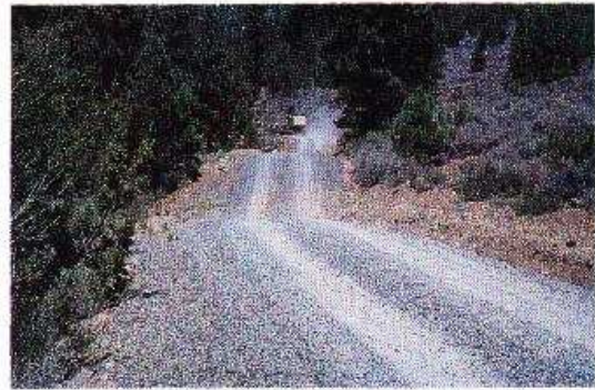
Foto 13-2. Un ejemplo de un camino rural de altas normas con la plataforma estabilizada con agregado triturado. Bosque Nacional Plumas, California, EE.UU. (Foto G. Keller)
