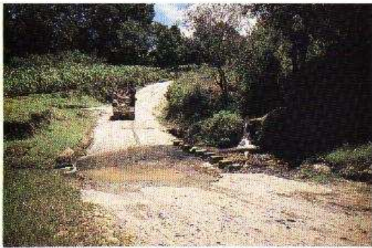
Foto 7-3. Un ejemplo de un badén de concreto mejorado resistente a la acción de socavación y erosión. Chimaltenango, Guatemala. (Foto G. Bauer)
