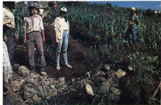
Foto 11-10. Un ejemplo del uso de estacas vivas de sauce con diques de contención de piedras. Huchuetenango, Guatemala. (Foto G. Keller)
