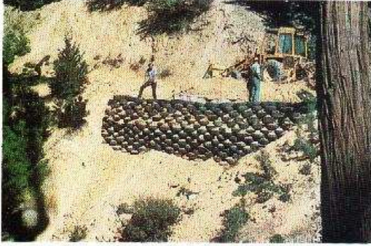
Foto 10-7. Se puede utilizar desechos o materiales locales para hacer estructuras para estabilizar taludes y controlar erosión. El uso de tales materiales como llantas usadas reducirá sustancialmente el costo. (GK)
