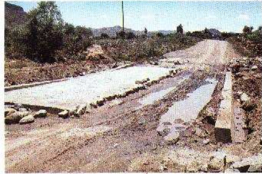
Foto 7-2. La construcción de un badén de concreto con muros de guardia que brindará protección a largo plazo con un costo de mantenimiento bajo. Chapare, Bolivia. (Foto G. Keller)
