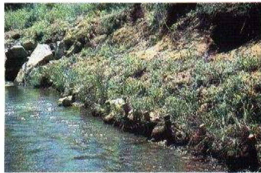
Foto 11-16. La orilla de un riachuelo donde ha sido utilizada la técnica de colchones de ramas hace 6 meses. Bosque Nacional Plumas, California, EE.UU. (Foto G. Keller)
