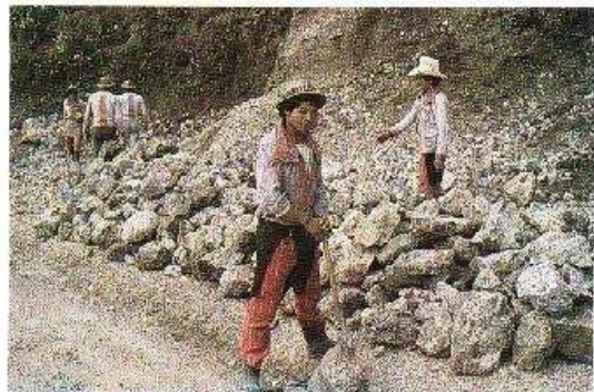
Foto 13-10. Un ejemplo del uso de mano de obra intensiva para seleccionar y triturar material para zamepado excavado de un banco de préstamo. Huehuetenango, Guatemala. (Foto G. Bauer)
