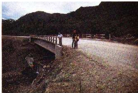
Foto 6-2. Un puente de tramo largo de concreto de normas altas. Chapare, Bolivia. (Foto G. Bauer)
