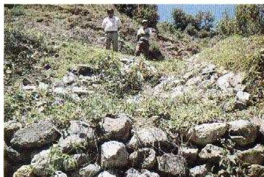
Foto 9-14. Una técnica recomendada donde se dispone de mano de obra y material local es el revestimiento de la salida de desagües con zampeado y la siembra de vegetación. Huehuetenango, Guatemala. (Foto G. Keller)
