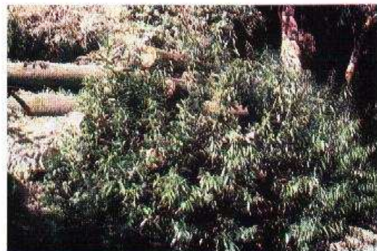
Foto 11-18. Una foto del mismo muro cribado vivo 4 meses después. Nótese el brote vigoroso de las ramas de sauce. Oakland Hills, California, EE.UU. (Foto A. Leiser)
