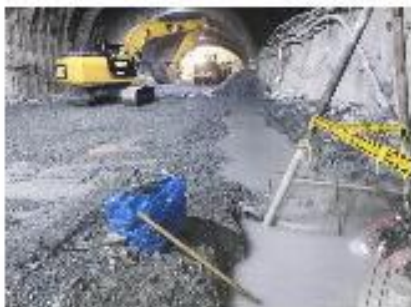
Zanja de conducción
